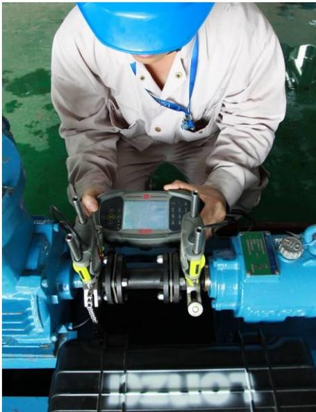
检查泵与电机之间的同轴度-激光对中仪
